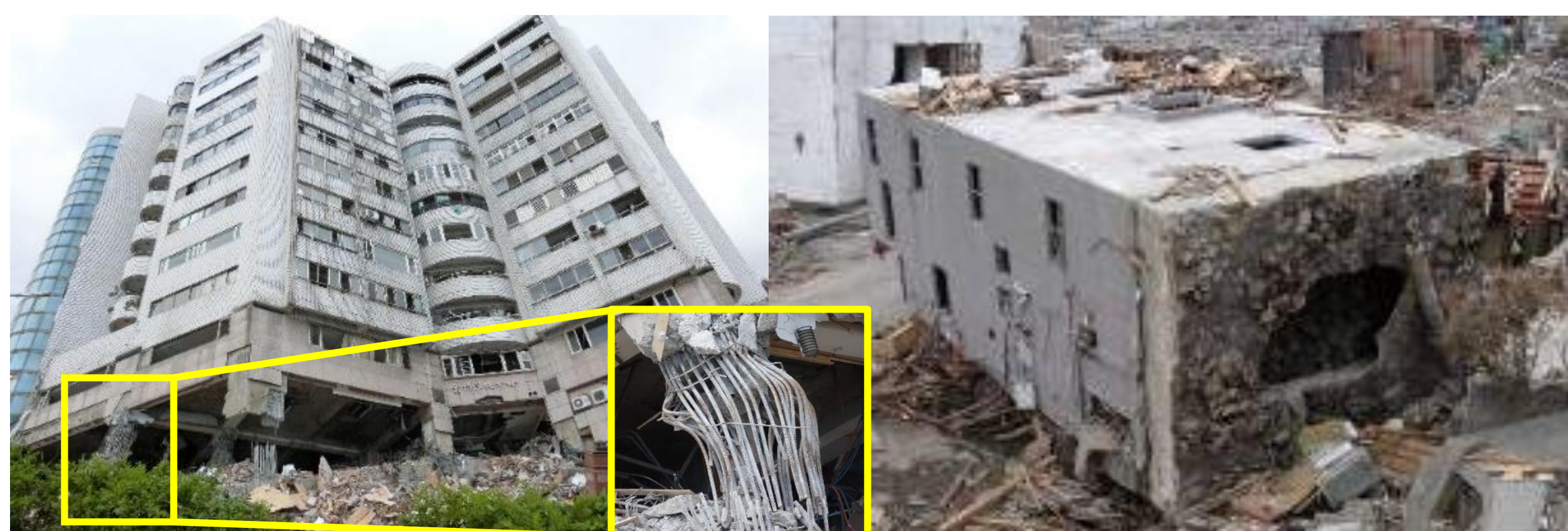
地震により倒壊した建物と柱の破壊
