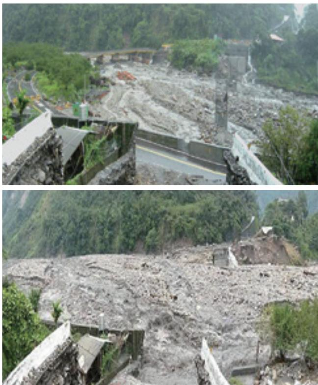
図2 2004年7月3日のMindulle台風による土石流に襲われた再建中のDongMao橋。上：台風前、下：台風直後。写真提供（Wei F Lee博士）
