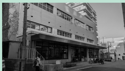
複合施設 R-DEPOT の外観
