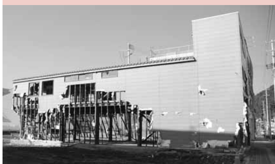
釜石高校は津波の被害はありませんでしたが、釜石市内には未だ津波の被害の爪痕が残っていました。
