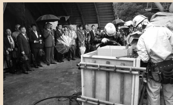
特別企画 ひび割れ自己治癒コンクリートの打設風景
