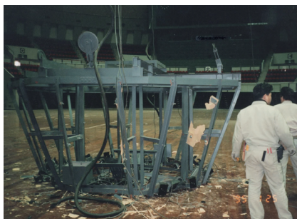
阪神大震災での大型設備機器の落下事例
