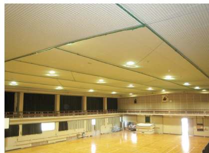
落下防止ネットの設置事例
