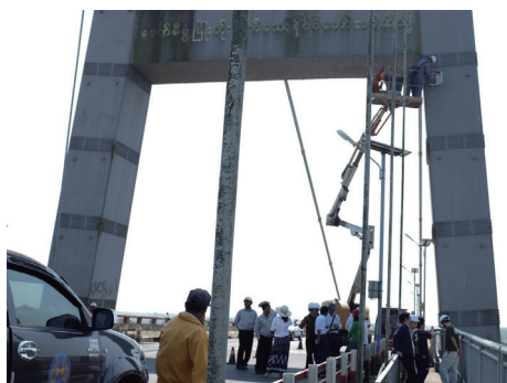
不具合のある吊橋のタワーの長期モニタリングのために傾斜計を設置（ヤンゴン市、ミャンマー） Installation of inclinometer for a long-term monitoring to the tower of a suspension bridge in Yangon, Myanmar
