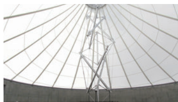
張力型空間構造モデルドーム観測システム Tensegrity frame system
