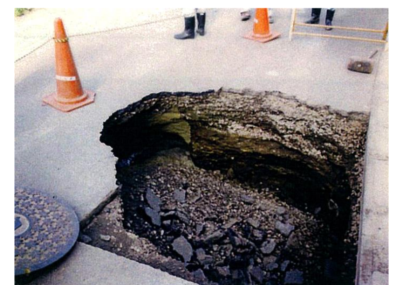
下水管の腐食による道路陥没
