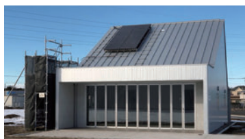
再生可能エネルギーシステムを導入した実験建屋 (REハウス) Test building with developed renewable energy system
