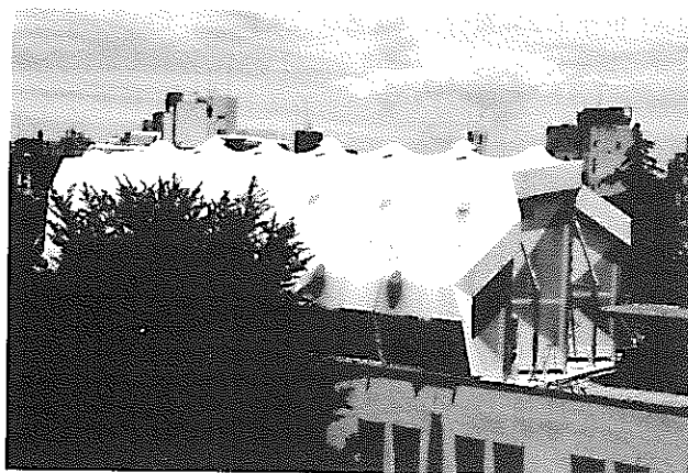
写真1 張る力安定トラス構造外観
