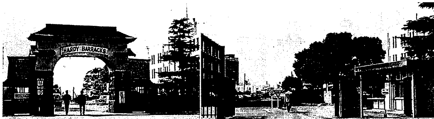
正門改修工事 本所の正門は米軍接収当時のままであったが、池辺教授の設計により改修工事が行われ新しい門(写真右)となった。
