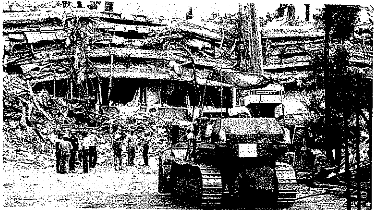
メキシコ地震調査 1985年9月19日メキシコ太平洋岸に発生したM=8.1の地震被害調査と復旧のため、ERSグループが活躍した。(写真はメキシコ市中心部における建物の破壊状況)
