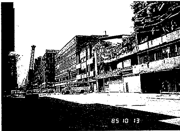
メキシコ地震：メキシコ市内地下鉄Pino Suarez駅前の崩壊した家電販売店
