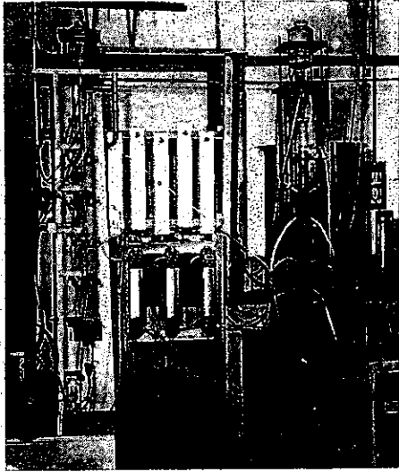
↑ 連続イオン交換装置 左塔は多段流動層式交換塔、右塔は移動床式再生塔である。(山本研究室)
