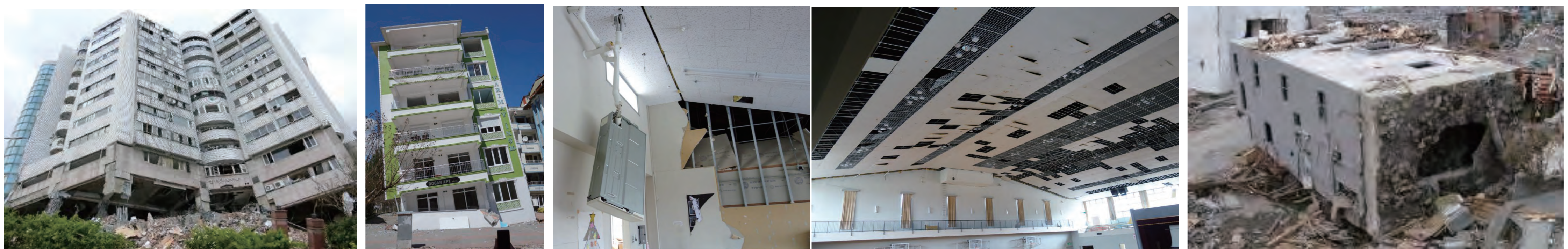
地震による倒壊建物 傾斜した建物 非構造物（設備機器，天井）の被害 津波により流出した建物
