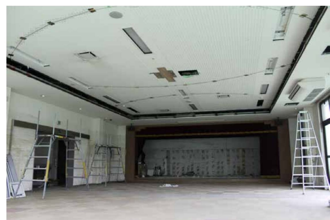
ケーブルによる天井の補強
