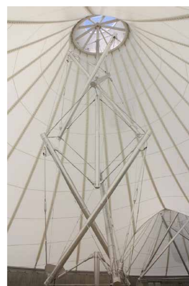
テンセグリティ構造の建設
