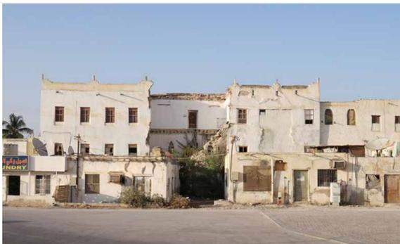
アラビア半島のオマーンで進めている石造家屋の修復プロジェクトです。中緯度乾燥地域のオマーンは木材資源に乏しく、いまでこそコンクリートの住宅が主流になっていますが、かつては石や土が中心でした。その構法を解明しながら、サイクロンで損壊した住宅を現代によみがえらせる取り組みです。
