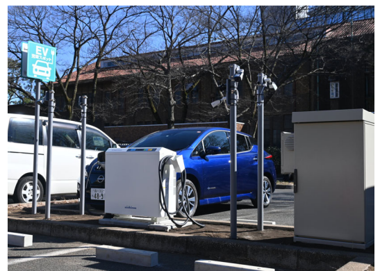
IoT技術を活用した研究用EV充電テストベッドの構築 (駒Ⅱキャンパス正門横駐車場)
