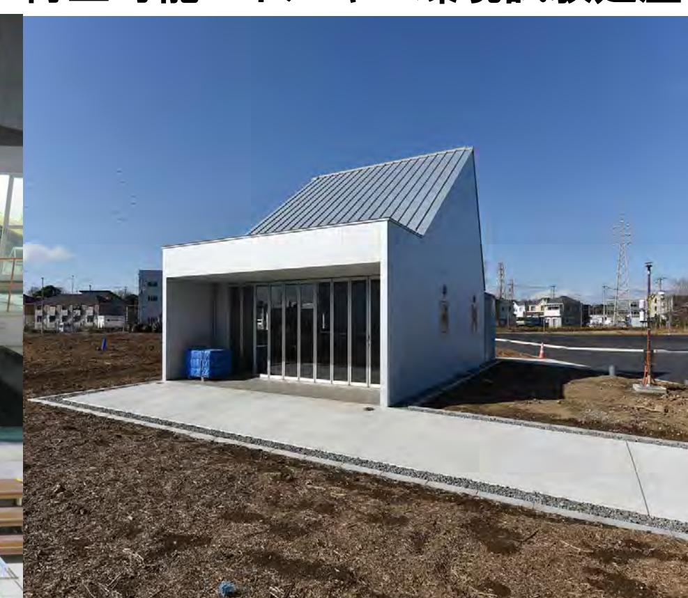
再生可能エネルギー環境試験建屋
