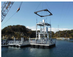
5kW 潮流発電装置の設置状況
