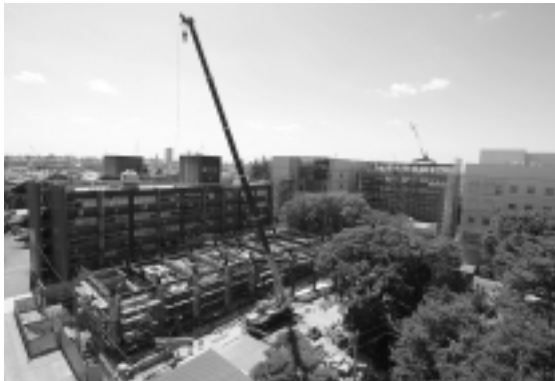
工事の進む総合研究実験棟
