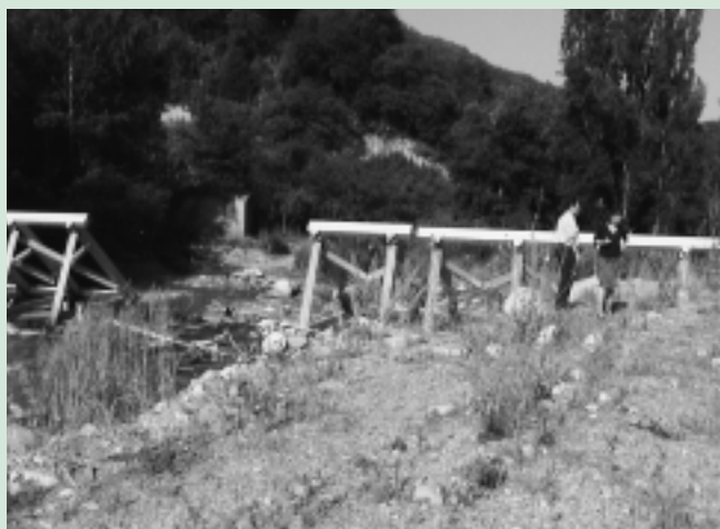
アルマティ川にかかる巨大な土石流防護柵(1970年代に大きな土石流災害があり、1991年のソ連からの独立後に作られた数少ない防災施設の一つ)。手前上流側に清水宏保氏が世界記録を出したメデオ・スピードスケートリンクがある。人物は秘書のベラさんと運転手のユラ君。
