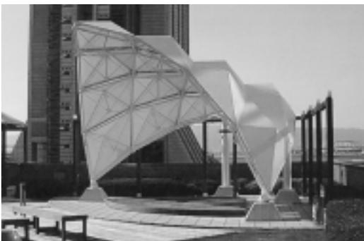
写真(1)「張力安定トラス」実用例
