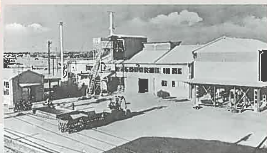
写真1 ▲創設当時の試験高炉設備全景 (1955年)
