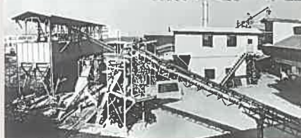
写真2 ◀最終型の試験高炉設備全景 (1982年)
