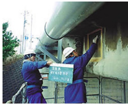
コンクリート表面の付着塩分量の測定
