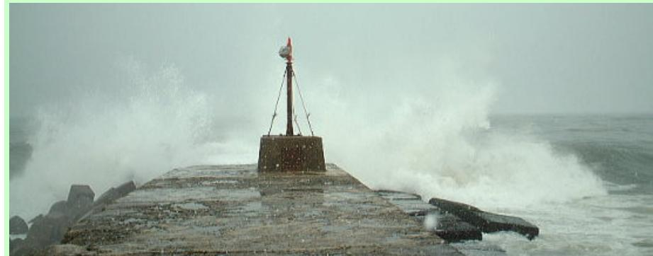
季節風により(特に日本海側), 波しぶきがコンクリート構造物にかかり, 塩害による劣化が問題となっている.
