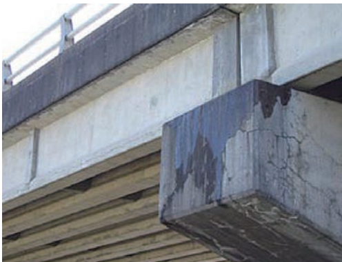
アルカリ骨材反応による劣化事例
