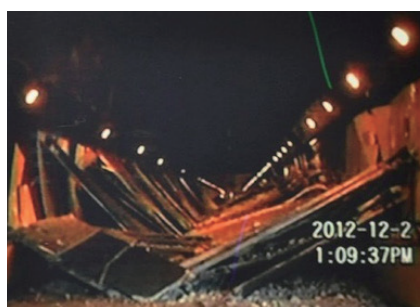
笹子トンネルにおける非地震時の天井落下事故 （写真は internet より）
