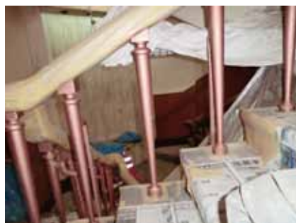
④ 銅粉の吹き付け
