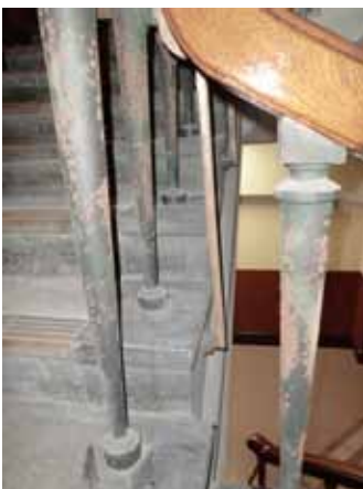
① 手摺子部分 補修前
