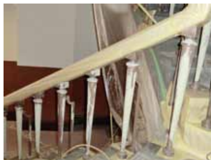
② 凹凸を無くすためのバテ処理
