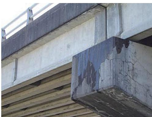
アルカリ骨材反応による劣化事例
