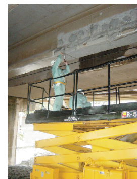
弾性波を用いた検査
