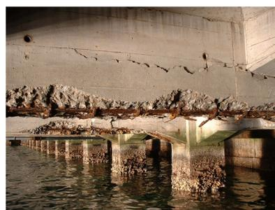
図2. 劣化現象の事例 (コンクリート構造物の塩害)
