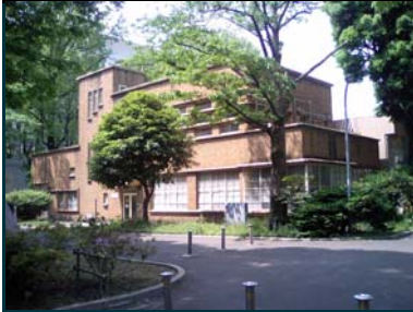
試作工場 17号館
