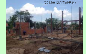
現地に建設中の実証研究施設 (2012年12月完成予定)
