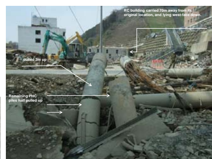
図3(下). 津波で引き抜けた杭：女川町で津波によって鉄筋4階建ての建物の杭が引き抜け、建物は70m流された。
