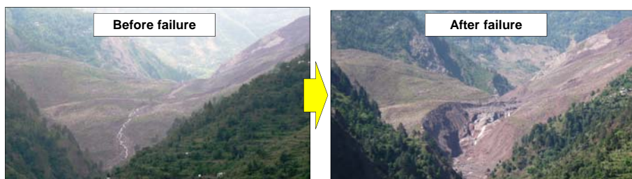
2005年パキスタン地震で形成された天然ダムが、2010年の中規模の降雨で決壊
