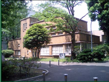
試作工場 17号館
