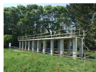
柱表層品質検証用RCラーメン模擬高架橋
