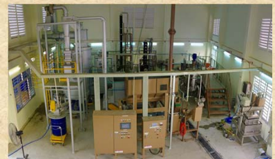
ホーチミン市工科大のバイオマス施設・プラント
