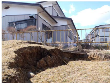
1978年宮城沖地震と同じ場所で崩壊した住宅地(仙台市)被災は盛土箇所に集中
