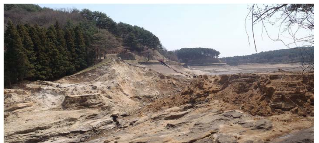
藤沼貯水地のアースダムが決壊(須賀川市)地震後不安定化した堤体が沈下して越流→決壊に至った可能性
