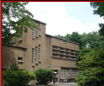
試作工場 17号館
