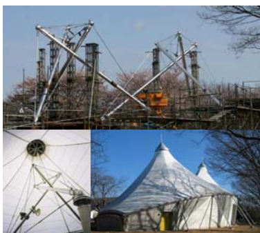
実大テンセグリティ構造(ホワイトライノ) Real-scale tensegrity structure (White Rhino)
