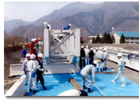
写真2 塗膜・塗料の塗布作業
