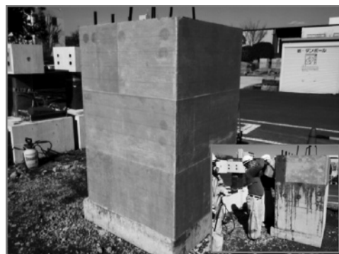
図6 柱試験体を用いた施工性能の確認
