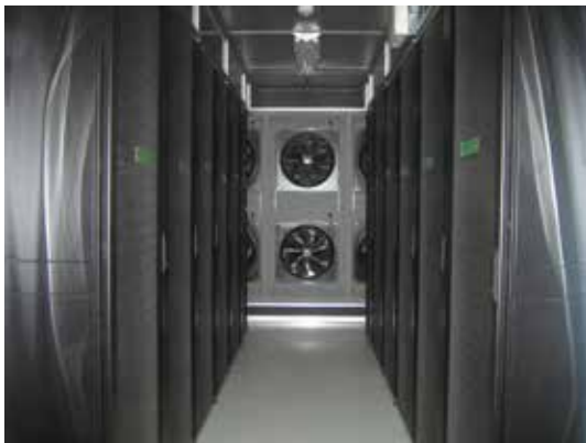
ビッグデータ解析基盤設備 Infrastructure for big data analytics
