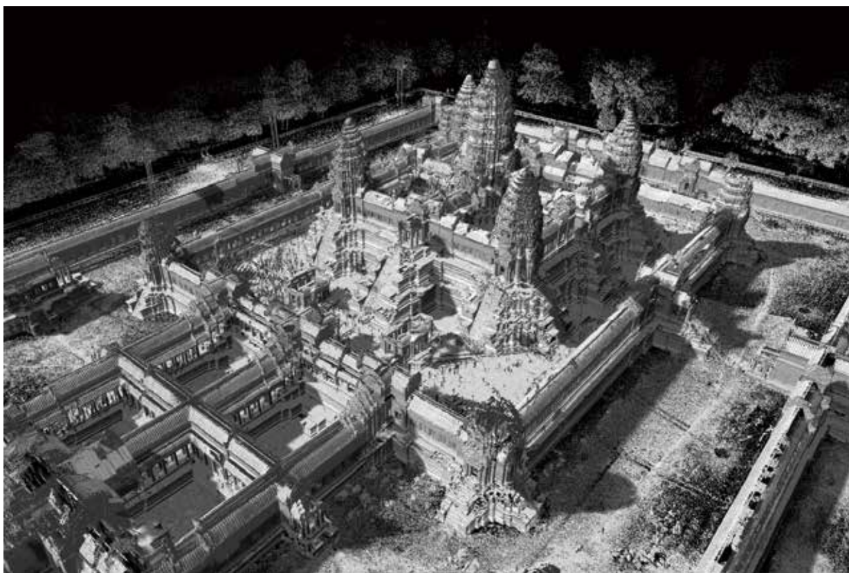
レーザー計測によるアンコールワットの3次元デジタルアーカイブ 3D digital archive of Angkor-wat by laser scanning technologies
