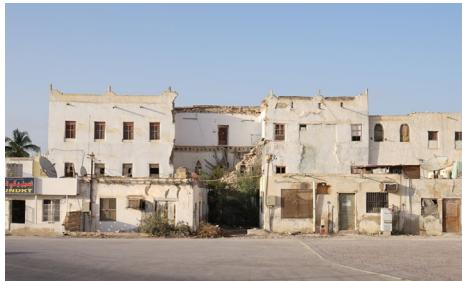
アラビア半島のオマーンで進めている石造家屋の修復プロジェクトです。中緯度乾燥地域のオマーンは木材資源に乏しく、今までこそコンクリートの住宅が主流になっていますが、かつては石や土が中心でした。その構法を解明しながら、サイクロンで損壊した住宅を現代によりみがえらせる取り組みです。
