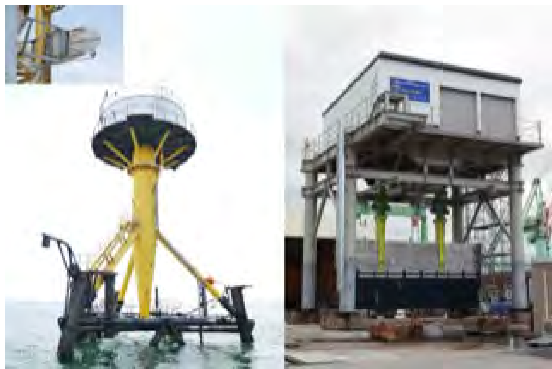
丸山研究室・海洋再生可能エネルギー
