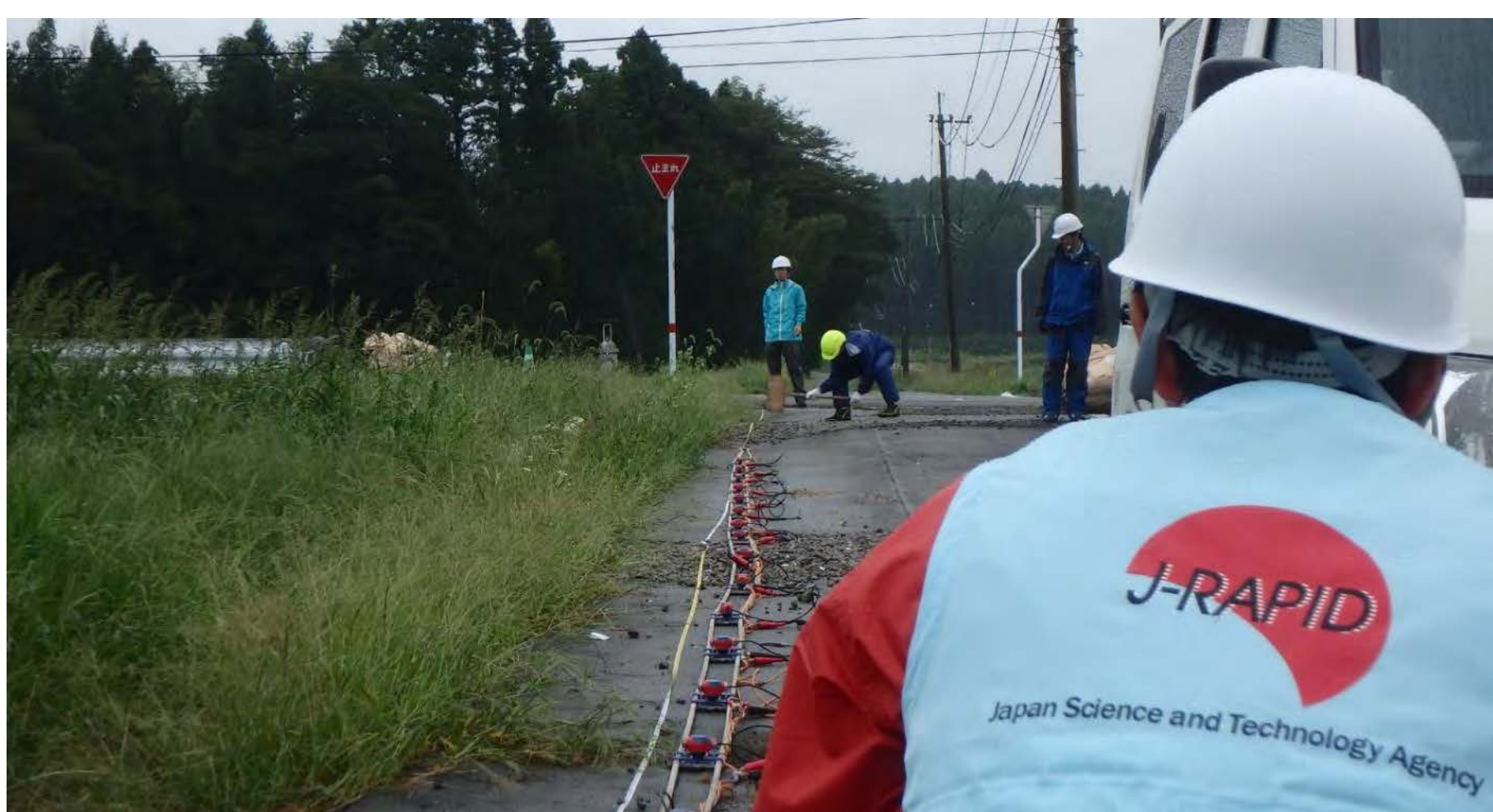
様々なツールを用いた現場調査を実施
