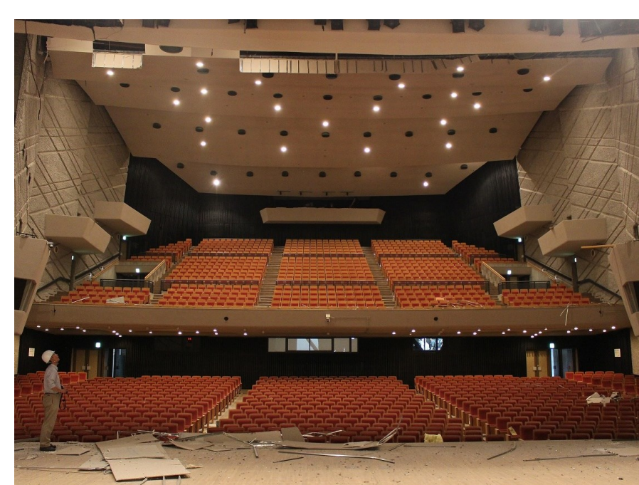
平成28年熊本地震の調査
