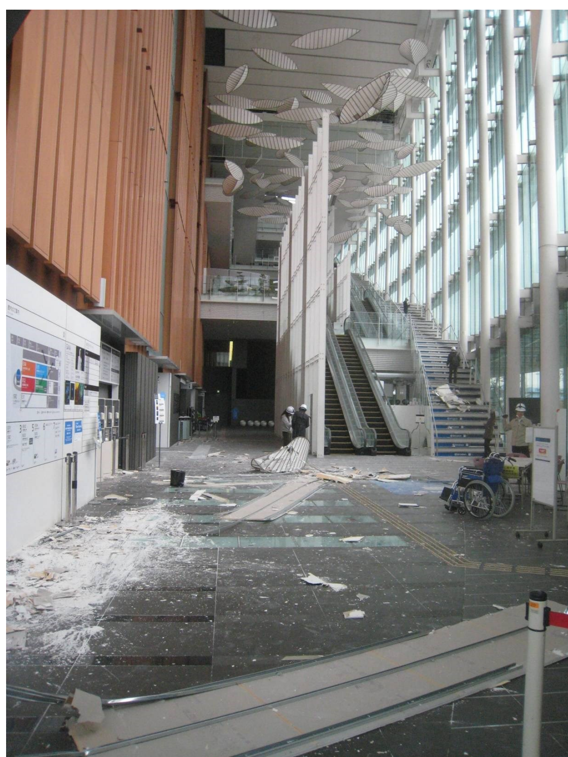
東日本大震災の調査
