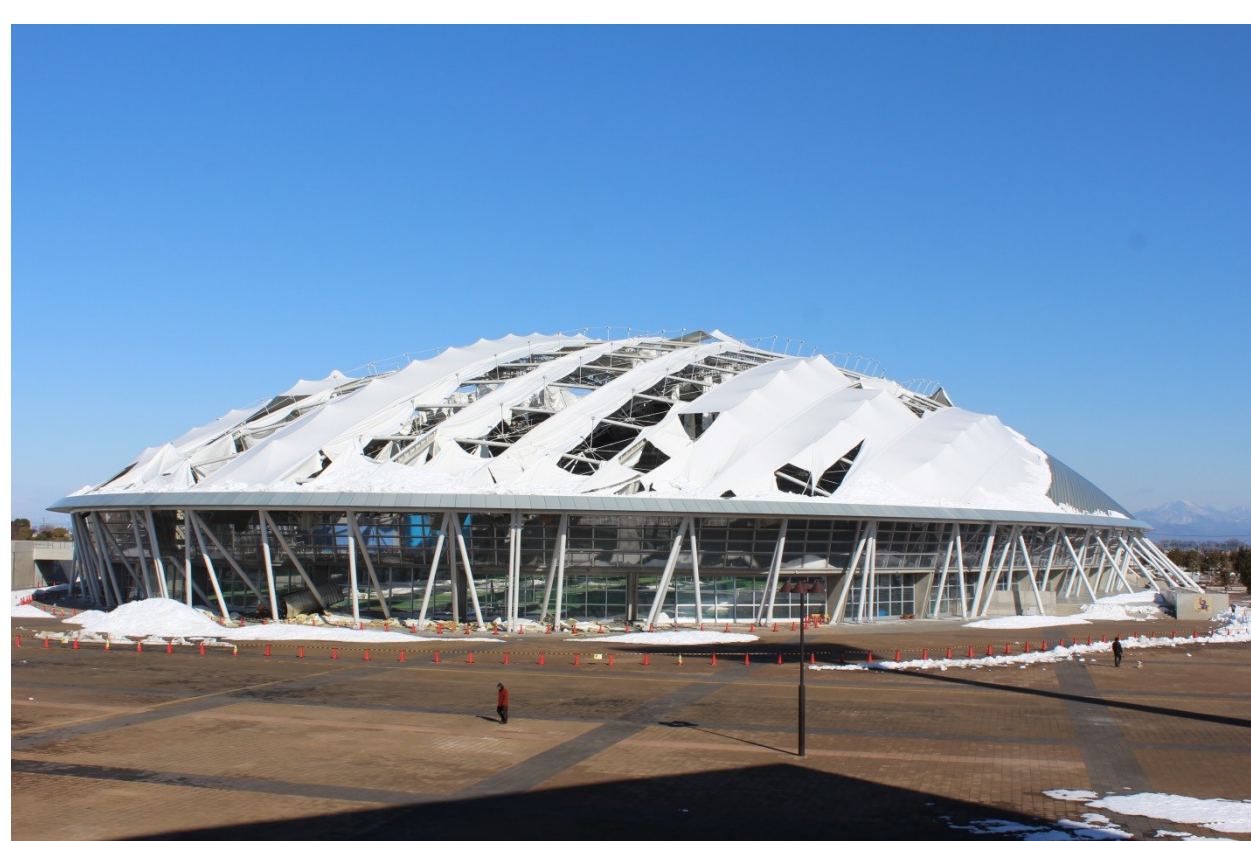
2014年2月14日の大雪による屋根崩落被害の調査
