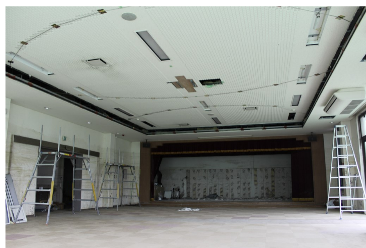
ケーブルによる天井の補強
