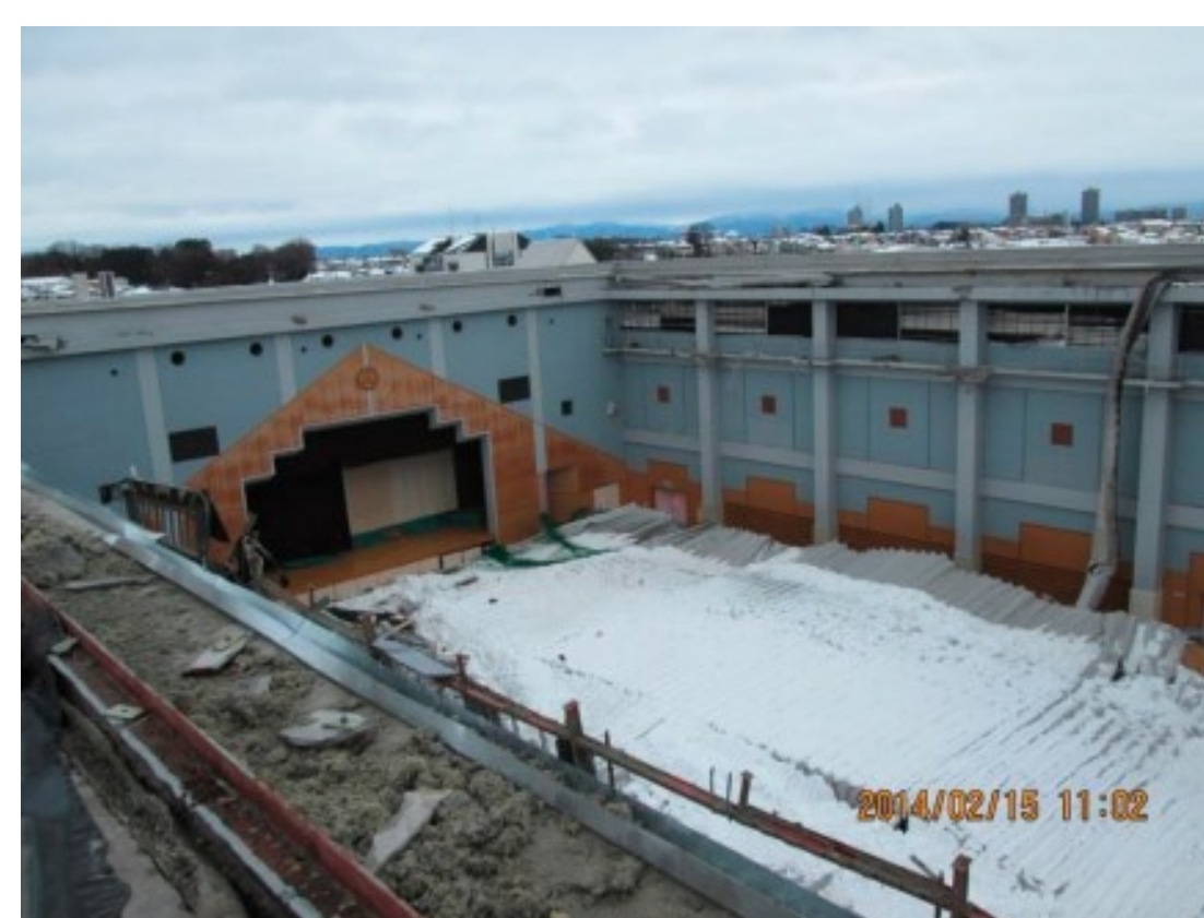
2014年2月14日の大雪による屋根崩落被害の調査
