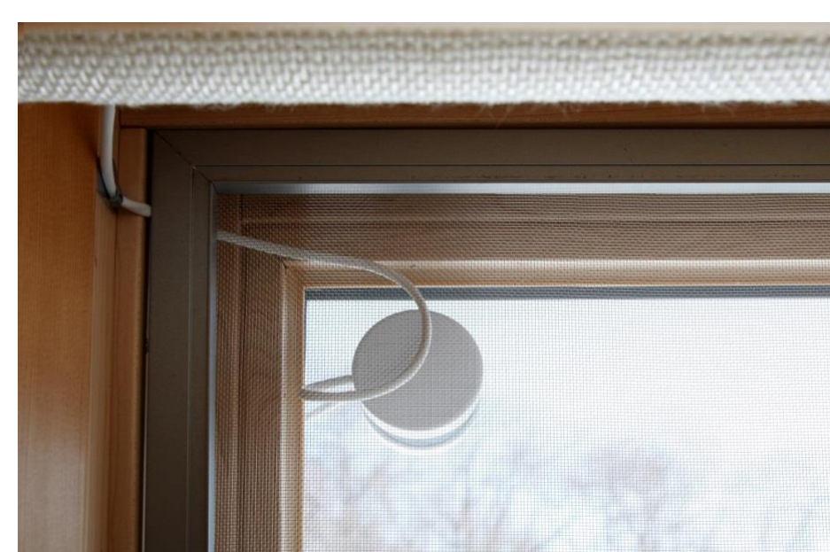
Window thermal sensors 窓面の温度計
