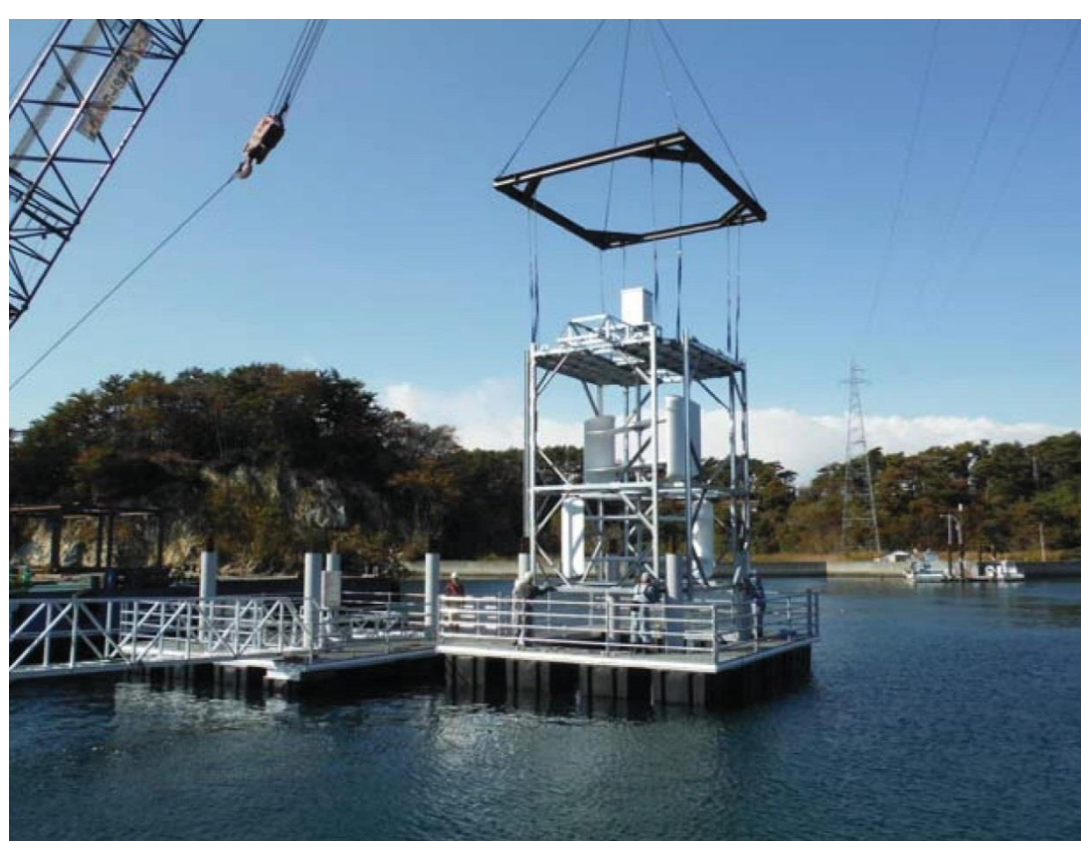
5kW 潮流発電装置の設置状況
