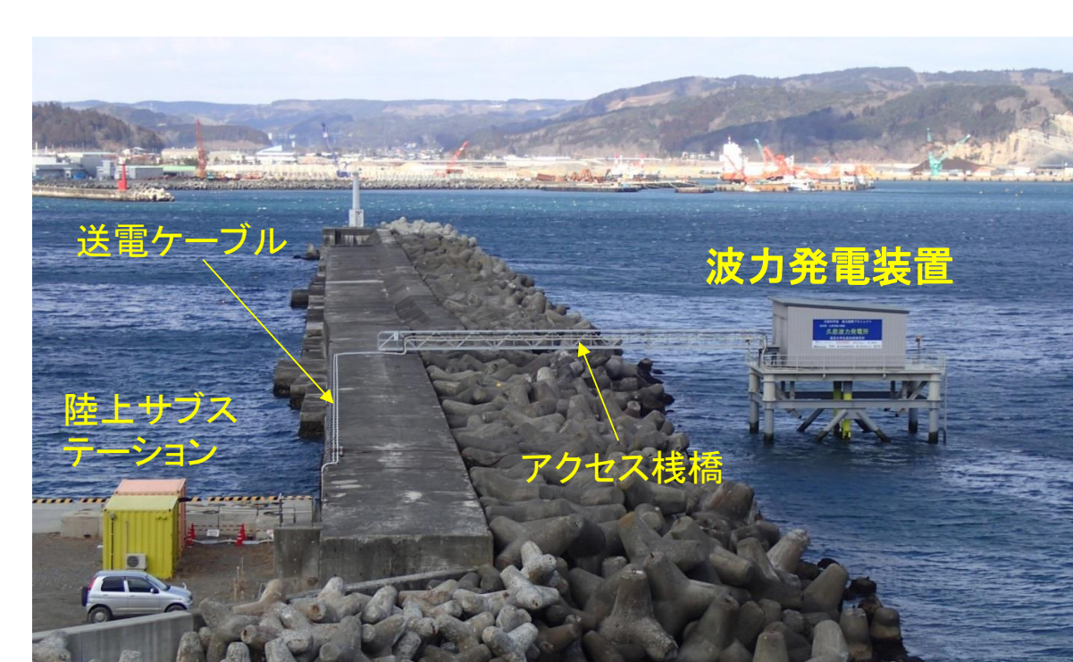
43kW 波力発電装置
